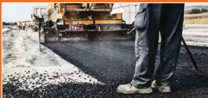
ZUNANJE UREDITVE (IZKOPI, NAVOZI, PLANIRANJE, TLAKOVANJE, ASFALTIRANJE, VODOVODI, PLINOVODI, KANALIZACIJE)
